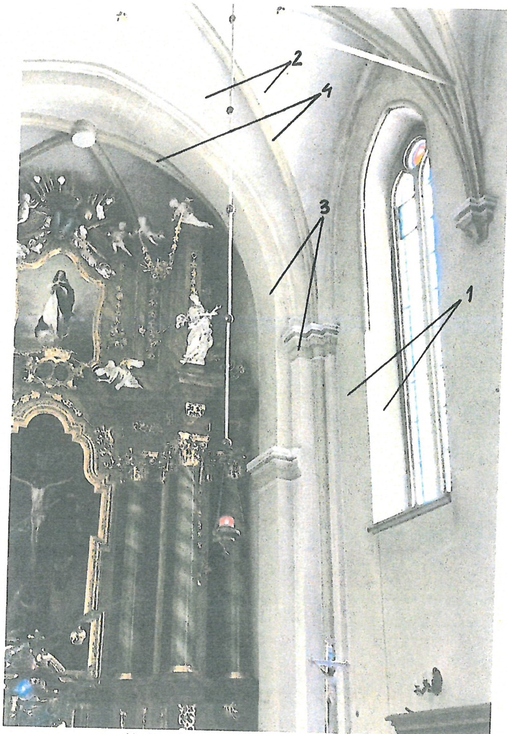
- prezbiterium - fragment ścian i sklepienia ( str. pld.)
